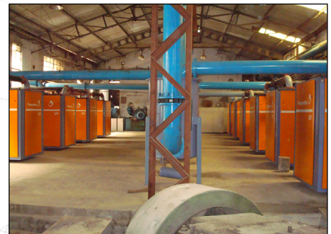
Машинный зал с 10 насосами модели UV50 VS90 HC
