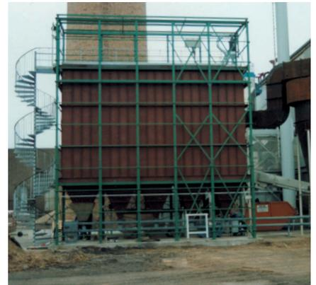
Schlauchfilter mit Trockensorption in Heizkraftwerk mit Restholzfeuerung
