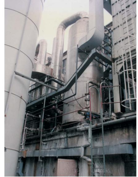
REA (Rauchgas-Entschwefelungsanlage) mit Sprüh-Nasswäscher, 25.000 m<sup>3</sup>/h 200° C
