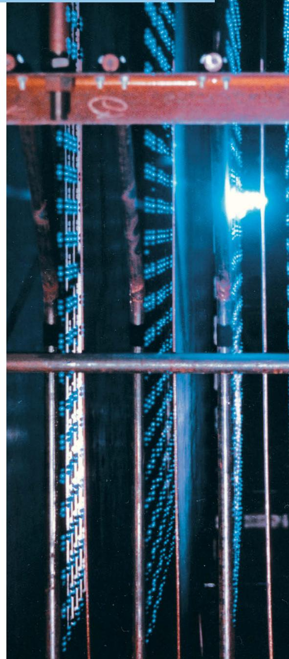
Blick in den Abscheideraum eines Horizontal-Elektrofilters
