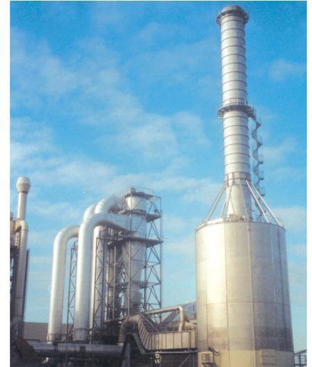
*Abgasreinigungsanlage für 2 OSB-Trockner; Systemkombination aus Quenche, Nasswäscher, Dual-Nasselektrofilter mit aufgesetztem 60-m-Kamin*
