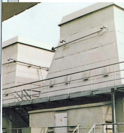
Schlotköpfe von Vertikal-Brüden-Elektrofiltern hinter Braunkohletrocknungsanlagen
