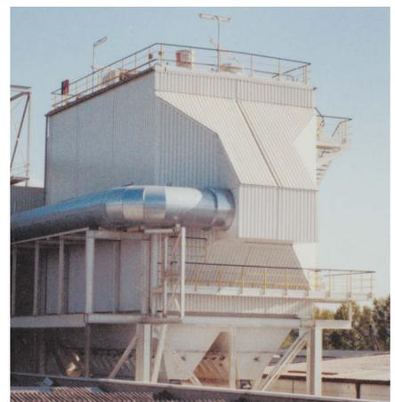
Zweistufiges Heißgas-Trockenelektrofilter für Glaswannentstaubung
