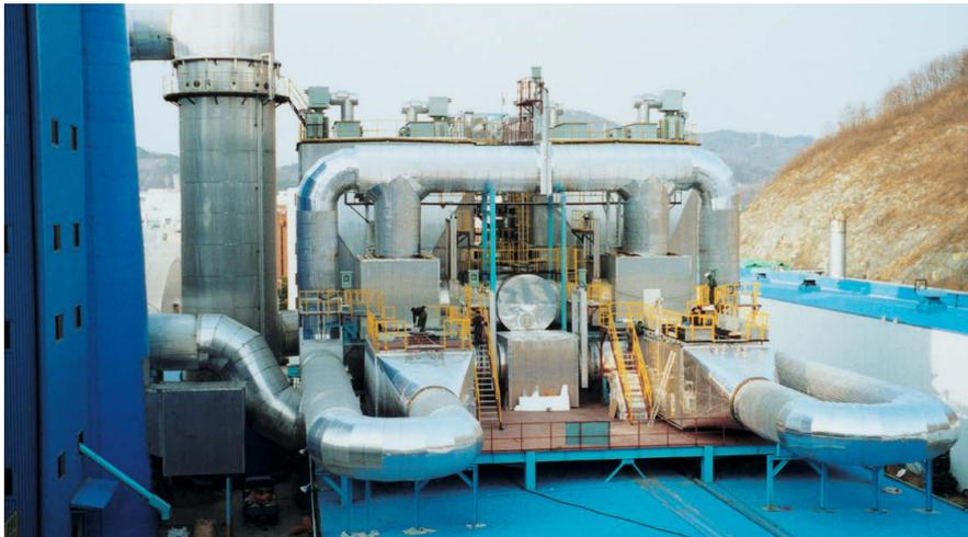
*DeNO<sub>x</sub>-Katalysatoranlage für Glasschmelzwanne; 2 x 152.300 m<sup>3</sup>/h*
