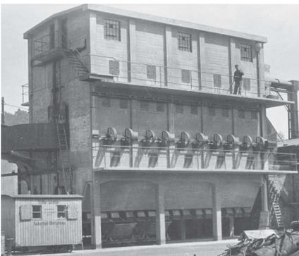
1924 Trockenelektrofilter für Gichtgas
