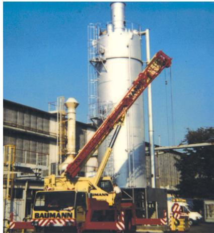
Vertikal-Nasselektrofilter für Aerosol - abscheidung in der Kunststoffindustrie
