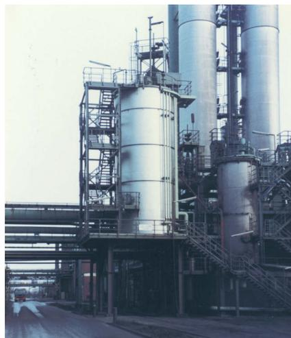
Vertikal-Rundelektrofilter für Kokereigas
