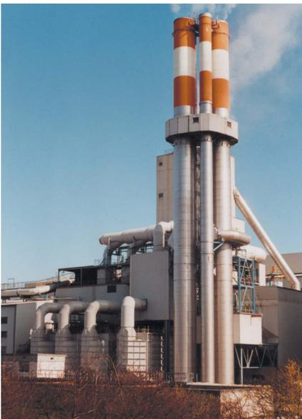
Horizontal-Nasselektrofilter für Tunnelofen- und Fallschachtabgase je  $100.000 \text{ Bm}^3/\text{h}$
