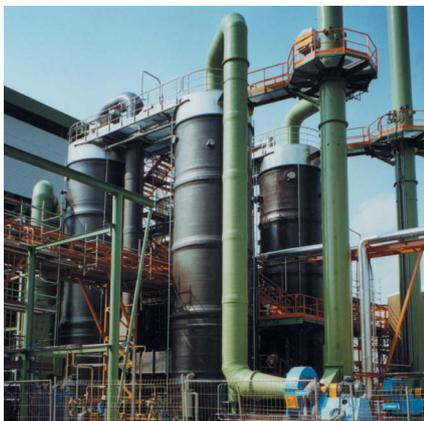
*2 Linien mit je zweistufigem Nasselektrofilter mit Sonder-GFK-Gehäuse und hochwertigen Edelstahlbauten für Flüssigabfall-Verbrennung nach Vorabscheidern; je 37.000 Bm<sup>3</sup>/h, Abscheidegrad > 99,5%*
