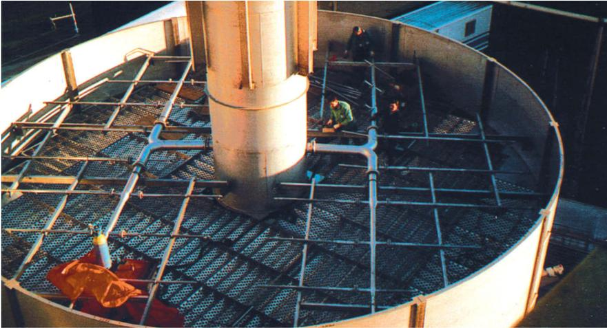
Gasverteilerboden als verstopfungsunempfindliche Wäscherpackung in Kombination mit einem Nasselektrofilter
