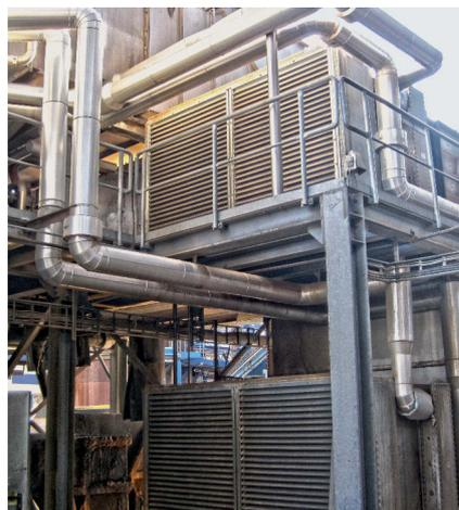
Wasser/Luft-Wärmetauscher für Verbrennungsluftvorwärmung von Trocknern
